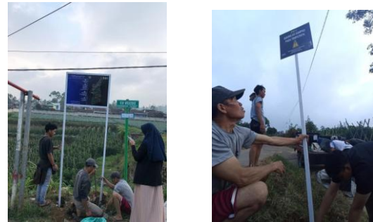
Gambar 1. Pemasangan Papan Informasi
